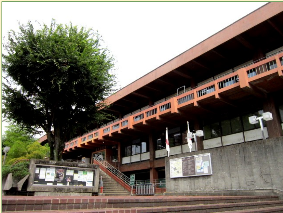
埼玉県さいたま市浦和区高砂3-1-22 (昭和35年3月「埼玉県立図書館」新館舎落成、昭和45年4月「埼玉県立浦和図書館」に名称変更、平成27年3月廃止)
