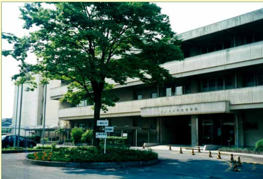
埼玉県川越市新宿町1-17-1 (昭和50年10月開館、平成15年3月廃止)
