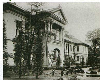
県立埼玉図書館（鳳翔閣 昭和9年）
