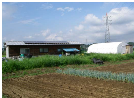
バイオガスプラント
