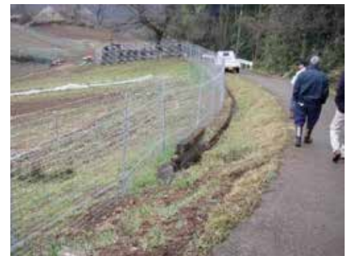
広域柵設置状況
