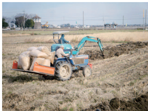
暗渠施工でもみ殻有効利用
