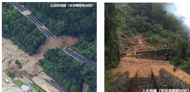
図 2.1.15 国道や鉄道の被災の例（平成 30 年 7 月豪雨、広島県）
