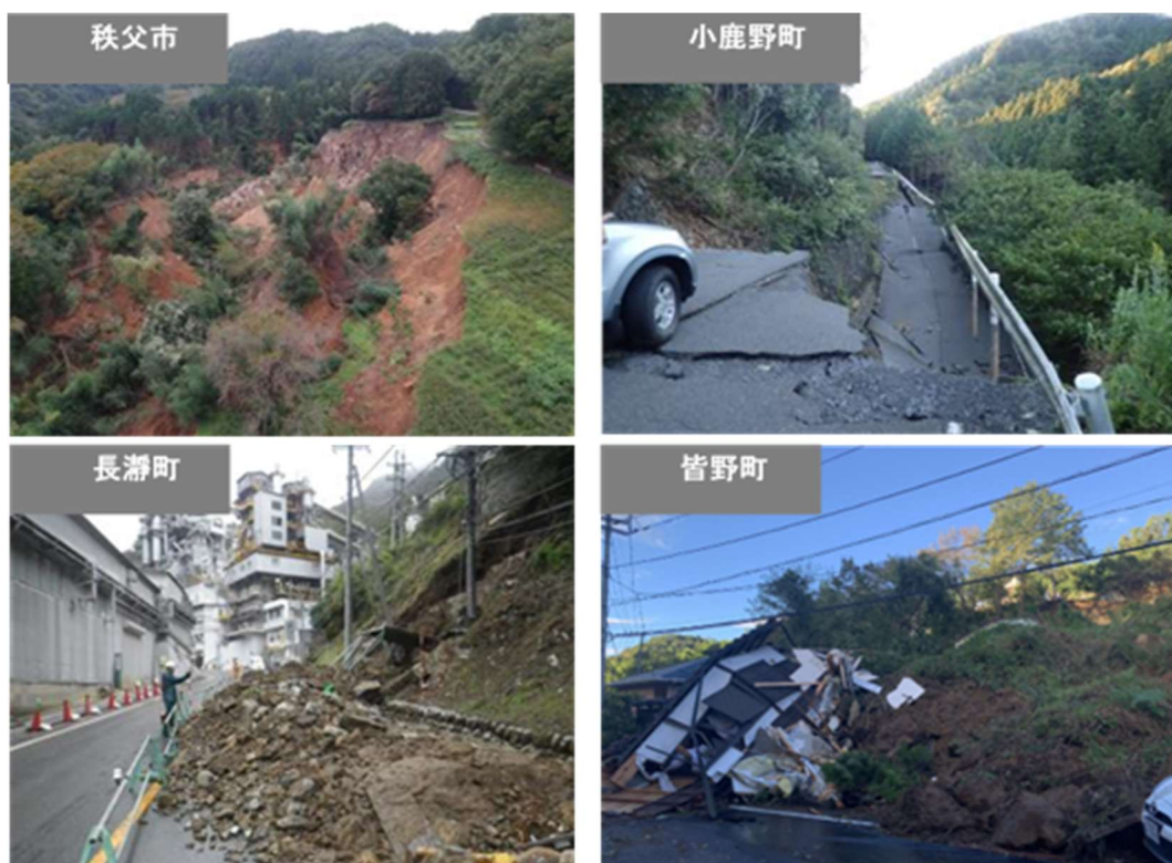
図 2.1.11 令和元年東日本台風で発生した土砂災害
