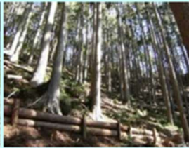
治山事業による整備
