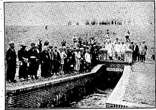
同組合用水樋管
