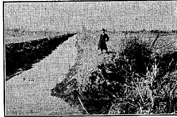
同地排水區改修後
