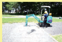
【建設機械実習】
