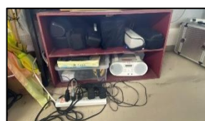
【図4】充電ステーション
